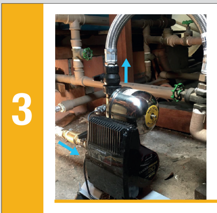
3) Buenas prácticas: a) Uso de flexibles (Facilitadores de instalación ROWA)
