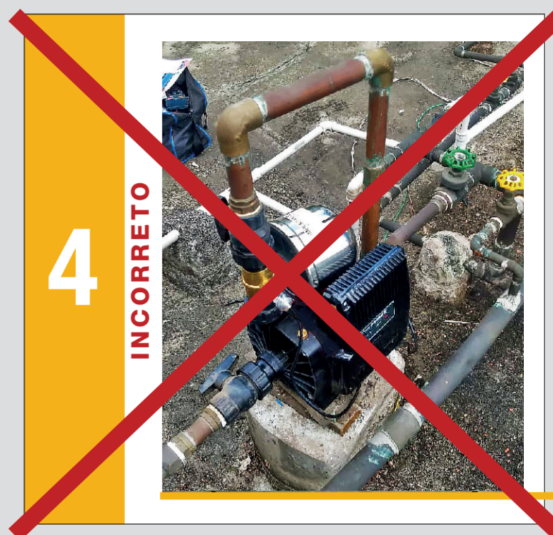
4) Mejoras: a) Equipo instalado a la intemperie b) Instalación sin la válvula original suministrada con el equipo.
